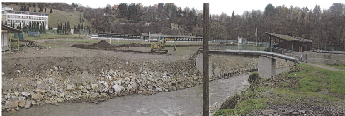
obr. 1 - km 1,04 - betonová lávka mezi fotbal. stadionem a areálem sportovní haly (pohled po proudu), v pozadí stabilizace paty levého břehu ocel. štětovnicemi, dřevěná tribuna, ocelová lávka přes Polečnici (jaro 2003)
